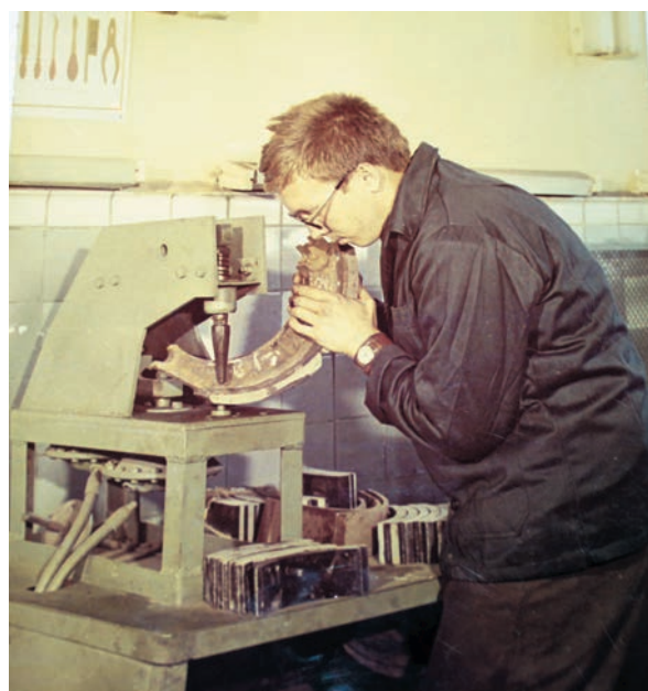
Станок для набивання заклепок на гальмівні колодки, Автобаза 0901, Вишневе. Фото початку 1980-х рр.
