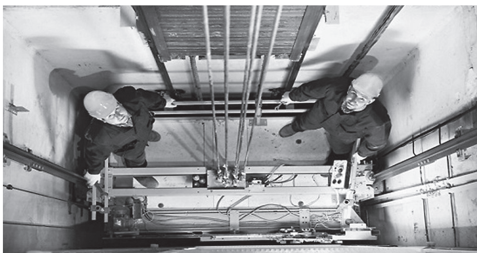
Ліфтова служба КП «УМГ» не тільки обслуговує ліфти, як це передбачено договором, але й ремонтує їх власними силами.
